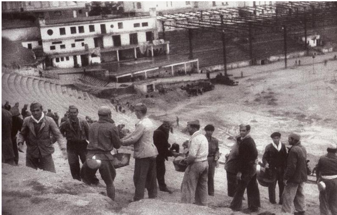
INICIO OBRAS "STADIUM METROPOLITANO"
