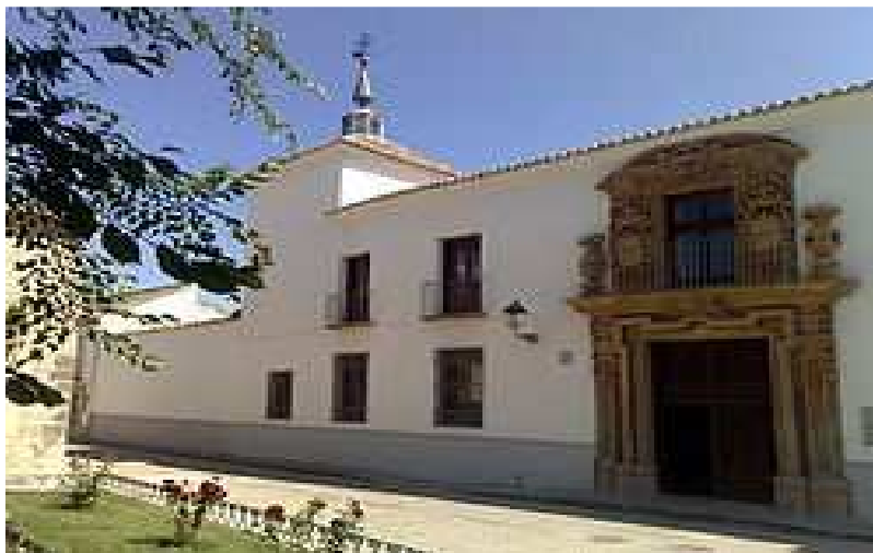
Fachada del Palacio de los Condes de Valdeparaíso.
